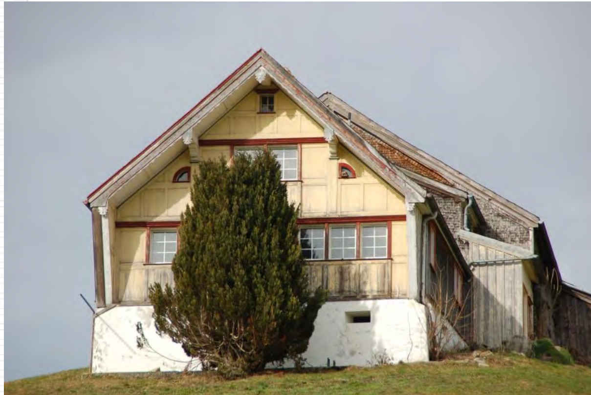
Bauernhaus Besserers, Lehnstrasse
